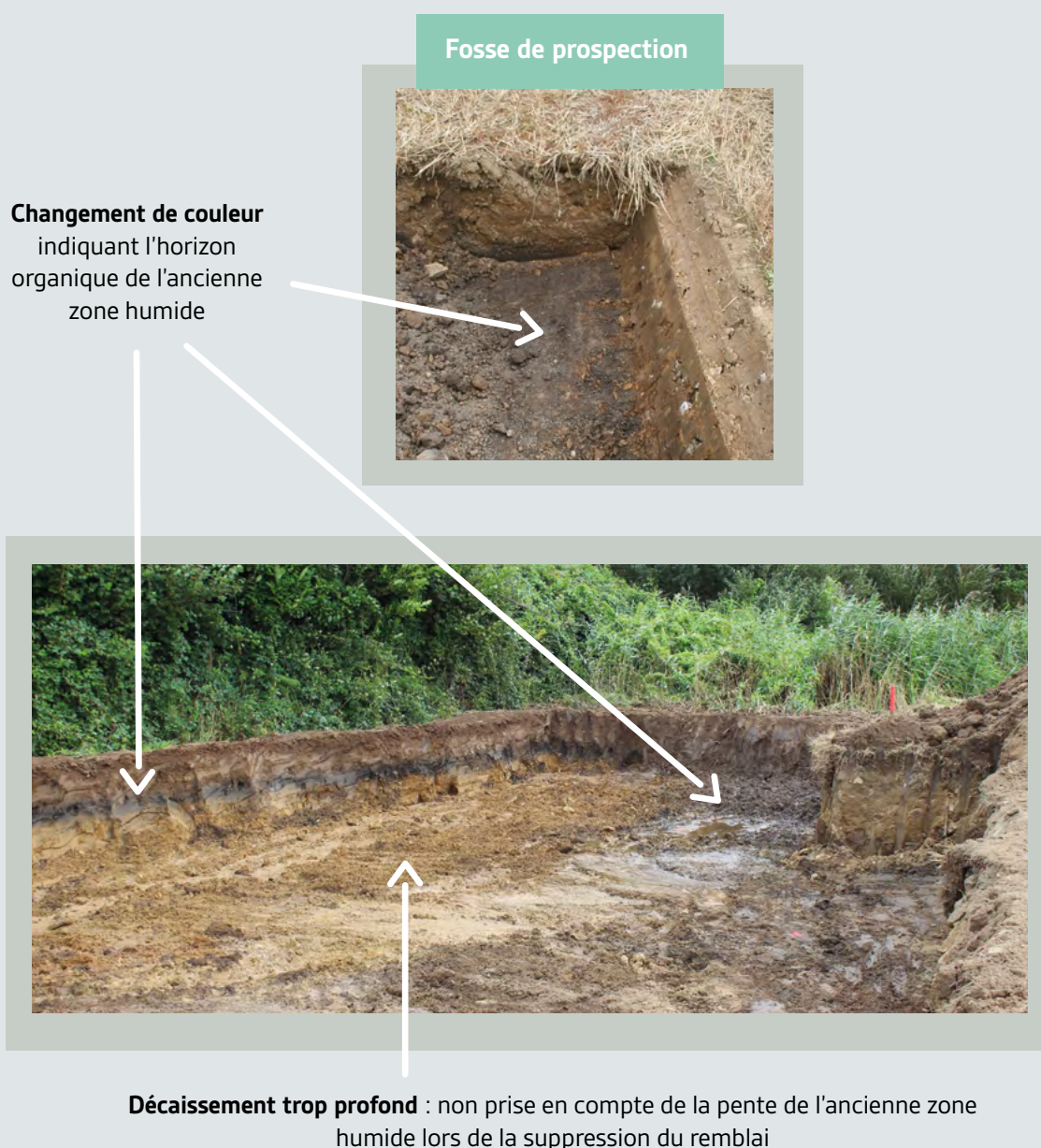
Figure 2 - Repérage de l'horizon organique de la zone humide sous le remblai
