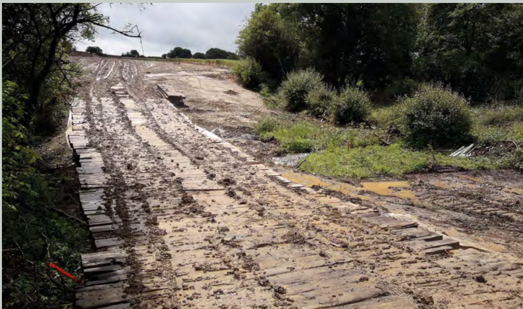
Plats-bords mis en place pour limiter l'impact du passage d'engins lourds sur le sol de la zone humide (© OFB).
